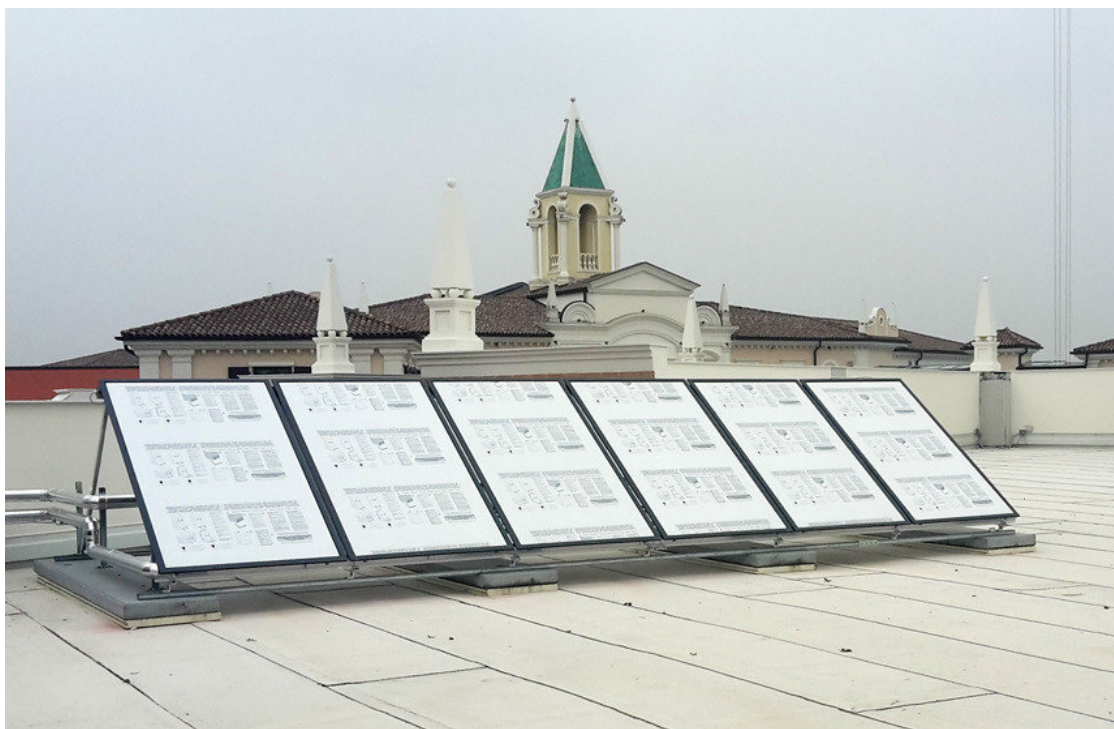
Pannelli solari per la produzione di acqua calda installati sul tetto dei nuovi blocchi servizi realizzati nel 2016(Fase 4.1).
