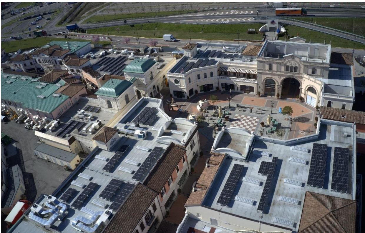
Foto scattata da drone in data 25/02/2021; si vedono i pannelli fotovoltaici installati sulle coperture dei nuovi edifici realizzati per le fasi IV e V di ampliamento.
