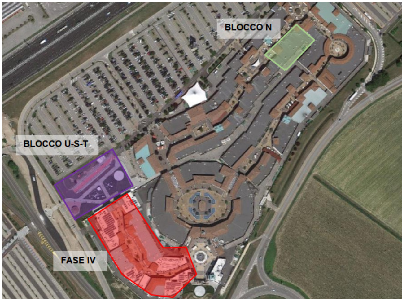
Superfici su cui sono stati installati gli impianti fotovoltaici (fonte: Relazione tecnica impianto fotovoltaico Noventa Designer Outlet, M&E Srl).
